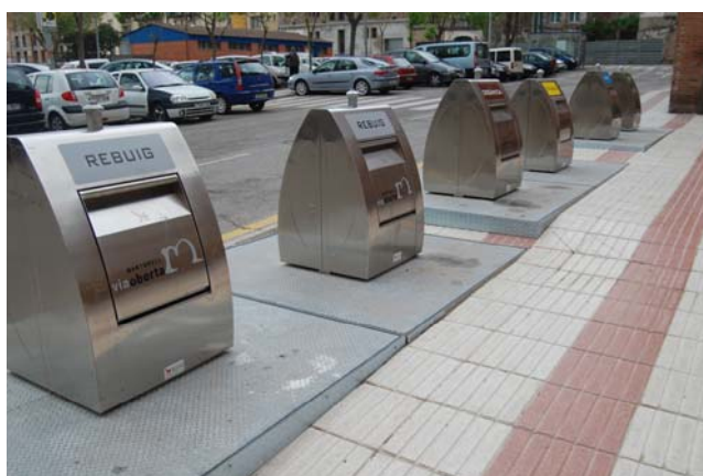
INSTAL·LACIÓ DE CONTENIDORS SOTERRATS
